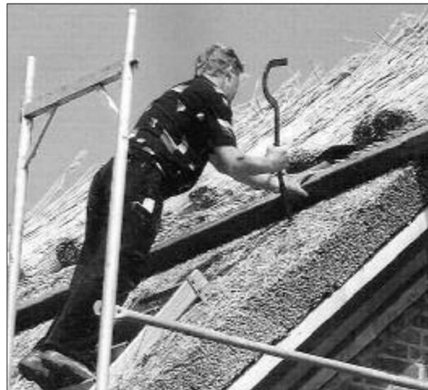
bündelt wird es zum Trocknen in Hocken aufgestellt. Anschließend wird es grob vorgereinigt, handelsüblich gebunden und gelangt über Großhändler direkt auf die Baustelle. Das Reet und die Firstabdeckung sollten Sie aus Gründen der Haltbarkeit mit Nirostadrath auf Ihr Dach binden lassen. Nirostadrath ist Garant für eine lange Haltbarkeit.
