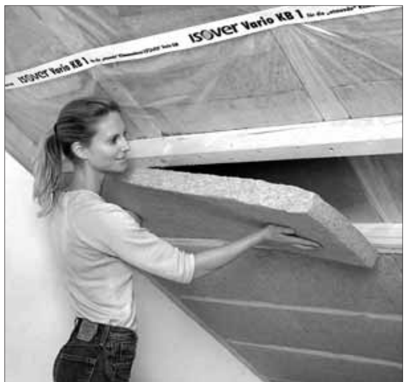
Dämmung, die nachwächst: Da Hanffasern kein Eiweiß enthalten, sind sie auf natürliche Weise resistent gegen Schädlingsbefall. Mit der Einstufung in die europäischen Baustoffklassen D und E bietet Hanfwolle auch einen wirksamen Brandschutz.
