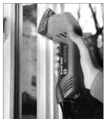
Bevor Farbeimer und Pinsel dran sind, muss der alte Anstrich erst gesäubert und angeschliffen werden.
