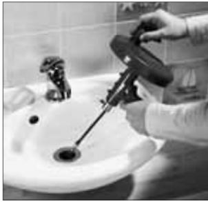
So kann man Abflussrohre von Waschbecken zügig reinigen
