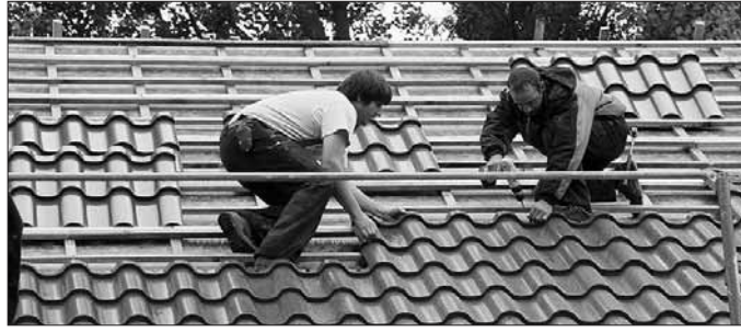
Ein Metalldach dieser Art kann alternativ mit Modulen oder durchgängigen Platten verlegt werden.
