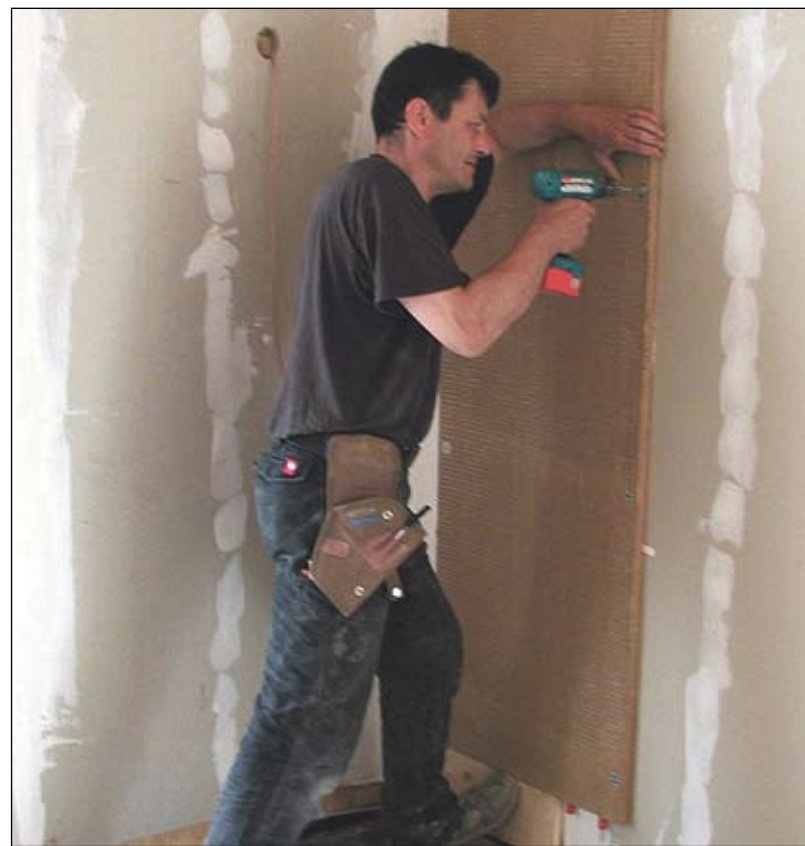
Das Klimatelement wird trocken auf der Wand verschraubt. Besonders geeignet ist das System für den Einsatz in Holzhäusern und Dachschrägen sowie bei der Renovierung. FOTO: EPR
