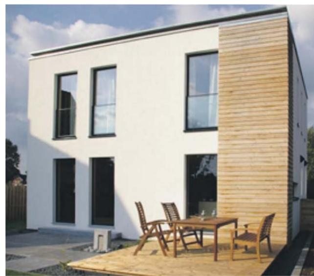
horizontal mit Holzdübeln leim- und chemiefrei zu raumhohen Elementen verbunden sind. Auf der außen liegenden Seite des Kerns wird eine durchgehende Dämmebene aus druckfesten Holzweichfaserelementen installiert. Alle Anschlüsse (Wand/Fenster, Wand/Boden, Wand/Decke, Wand/Dach) werden dadurch winddicht und wärmebrückenfrei überdämmt. So entsteht ein einstoff-
