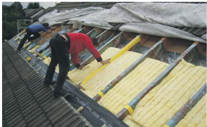
Von einer Fachfirma ausgeführte Wärmedämmungen am Haus bringen meist die optimale Energieersparnis.
