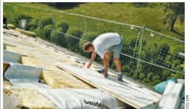
Eine typische Sanierungssituation: Der ausgebaute Dachstuhl ist innenseitig lediglich mit Gipskartonplatten verkleidet, die Zwischensparrendämmung technisch veraltet. Eine fachlich korrekte neue Dachdämmung hilft, künftige Heizkosten drastisch zu senken.
