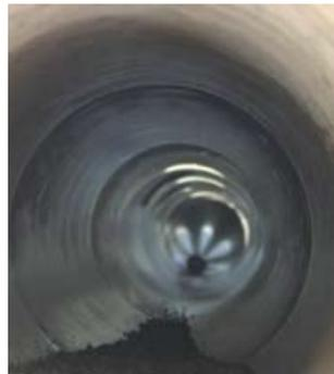
Blick in einen intakten Abwasserkanal mit leichten Ablagerungen
