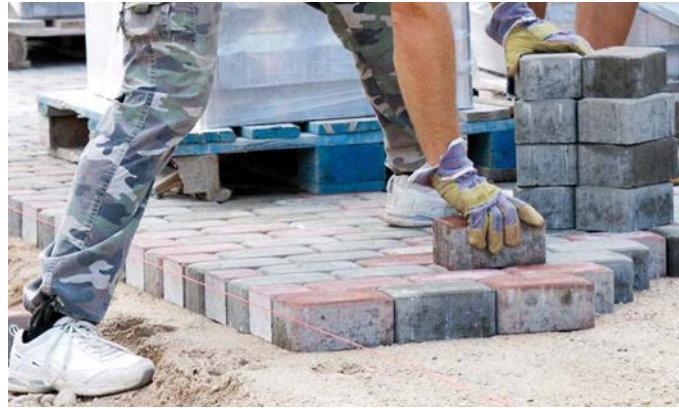
Je nach Verlegemuster wird Stein für Stein in die vorbereitete Bettung aus Sand, Kies oder Split gesetzt.
