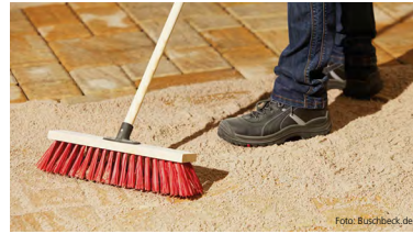
Ist nach der Pflasterung der Fugensand gewissenhaft eingeschwennt, haben Unkraut oder Ungeziefer kaum eine Chance.
